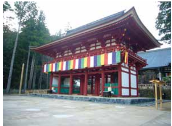
写真4 平成27年に再建された伽藍中門
